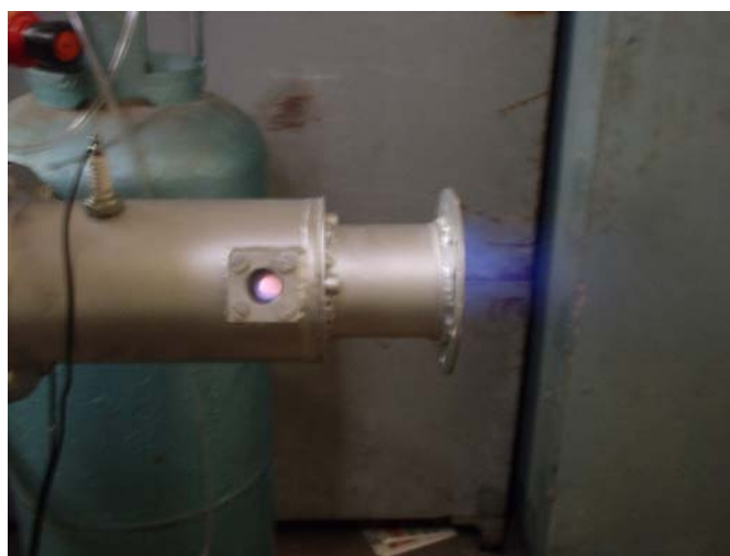
Fig. 5.13 - Câmara de Combustão operando
