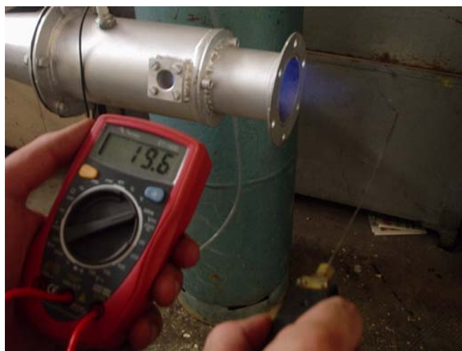
Fig. 5.8 - Foto da medição de temperatura
